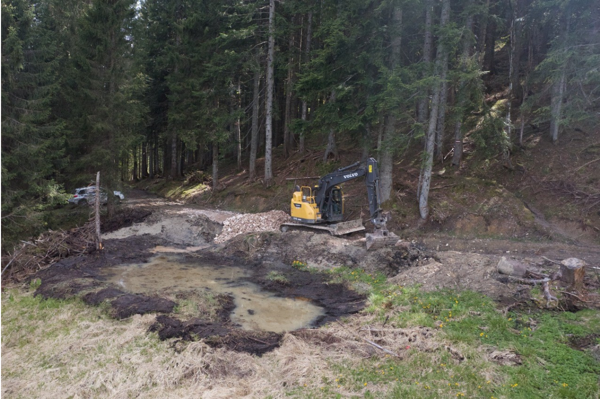
Anlage von Tümpeln im Zuge des Forststraßenbaus – kein großer Aufwand
